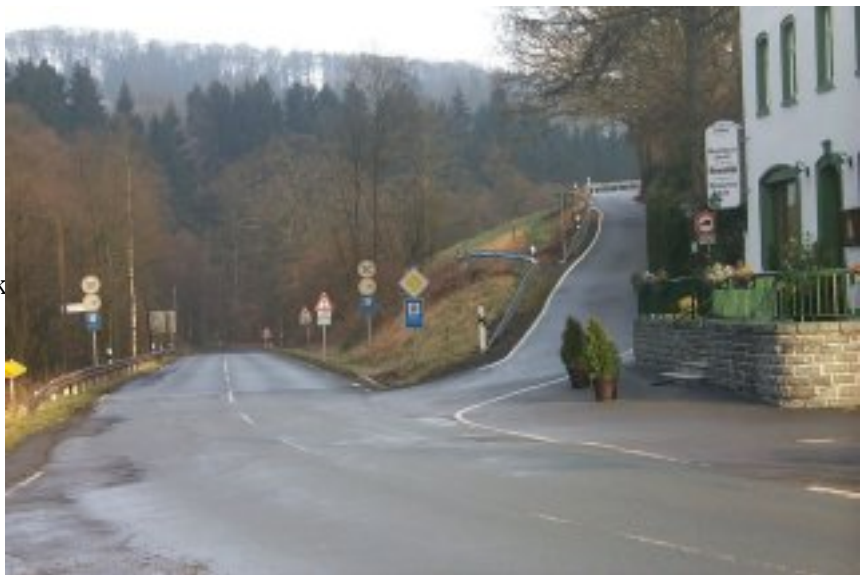
Km 6,9: Abzweig Richtung Stottmert
